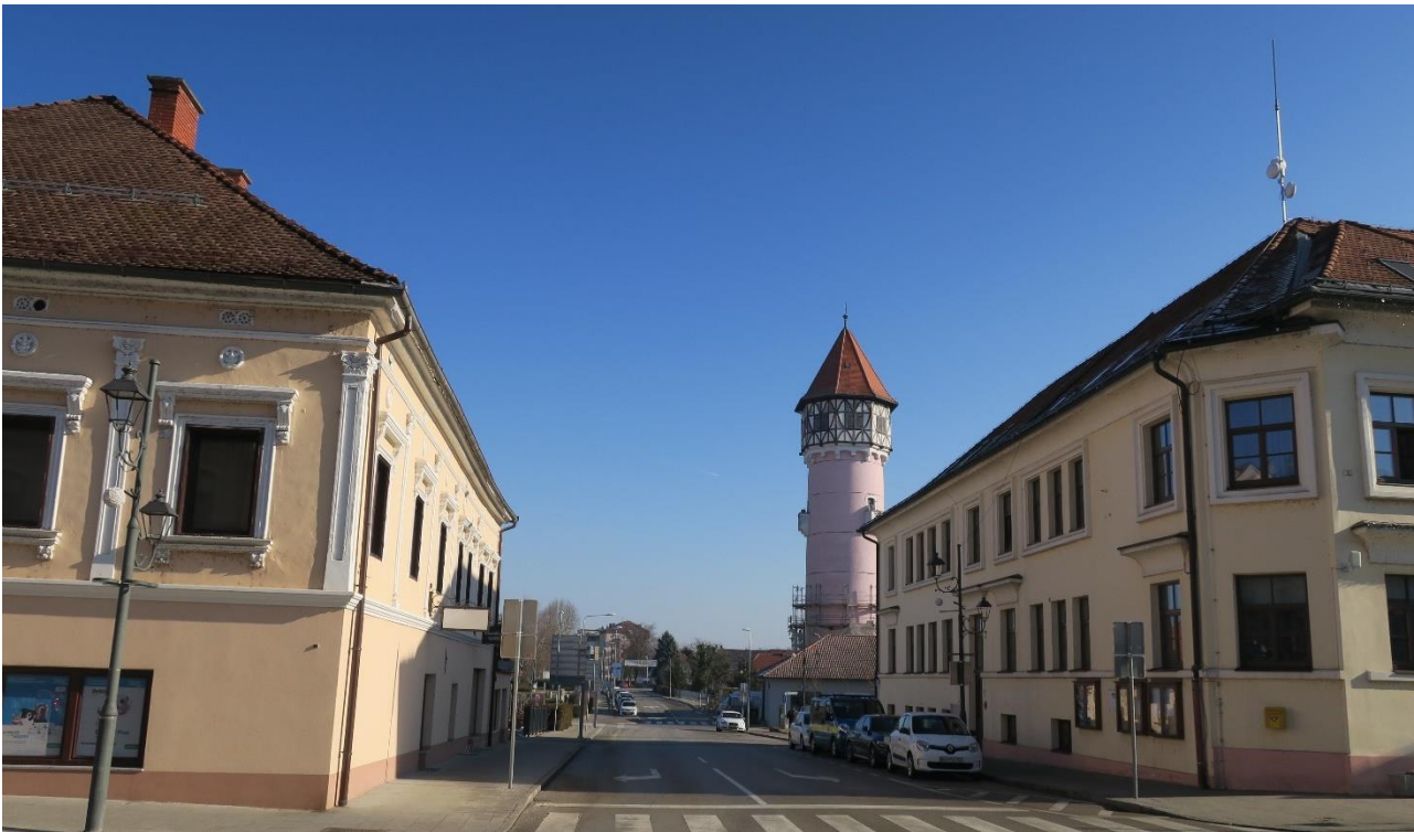
Slika 01: Sekvenčni pogled na vodni stolp.
