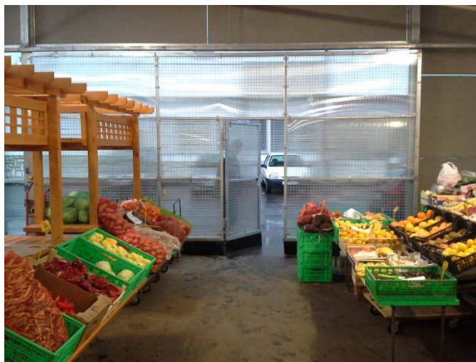
Slika 27: Protivetrna zaščita na tržnici Brežice
