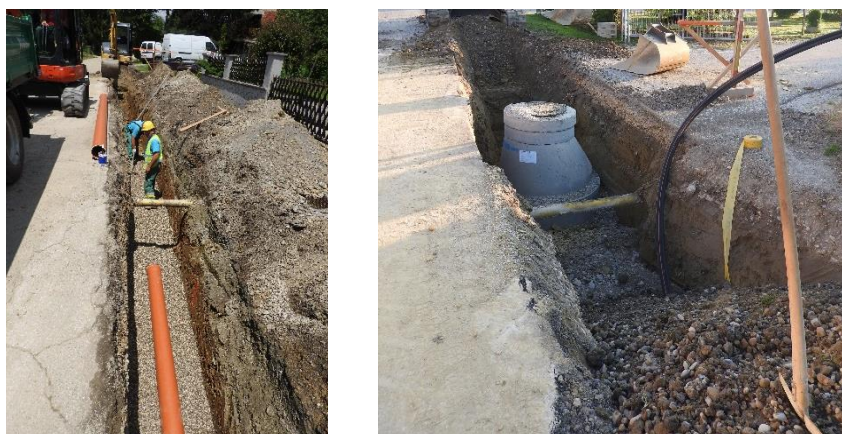
Slika 2: Izvedba kanalizacije v Gaberju
