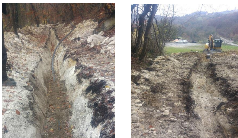
Slika 1: Izgradnja vodovoda Sromlje
