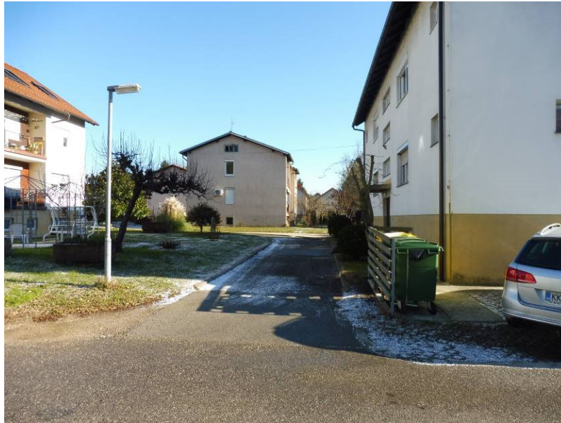
Slika 9: Gubčeva ulica – ne kategorizirane povezovalne ceste med objekti Gubčeva ulica 16, 18, 20, 22 in 24
