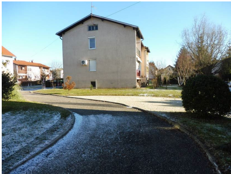
Slika 10: Gubčeva ulica – ne kategorizirane povezovalne ceste med objekti Gubčeva ulica 16, 18, 20, 22 in 24
