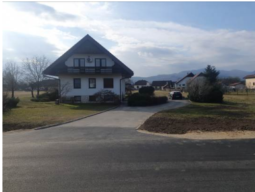
Stanovanjska hiša – sever
