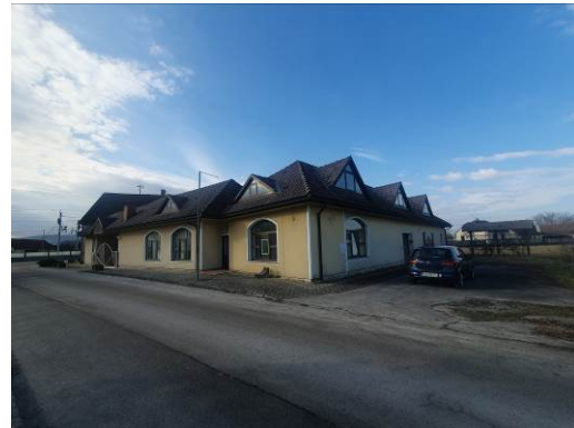
Poslovni objekt - jugovzhod
