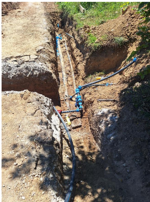
Slika 6: Obnova vodovoda Pišce
