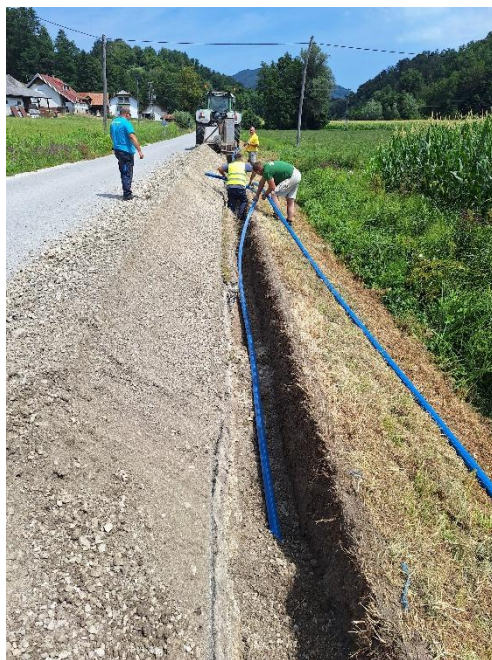
Slika 5: Obnova vodovoda Blatno
