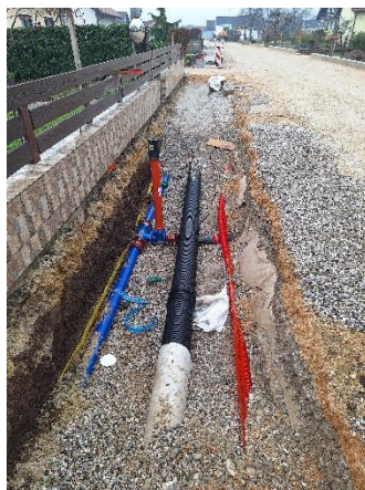
Slika 7: Obnova vodovoda – Cvetna ulica, Dobova
