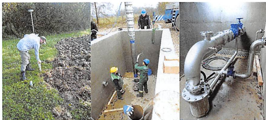
Slika 14: vgradnja črpalke na vrtini Glogov brod
