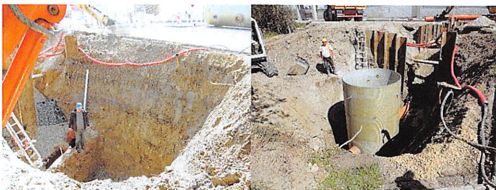
Slika 16: Izvedba črpališča Stadion
