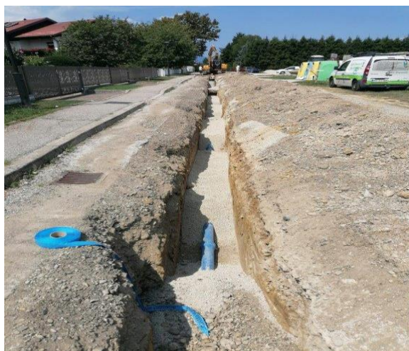
Slika 6: Izgradnja vodovoda Ulica Kozjanskih borcev
