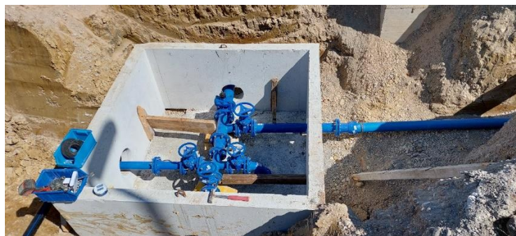
Slika 9: Izgradnja vodovoda Kera net – Gril
