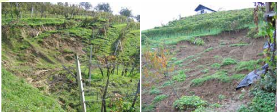
Sliki 2 in 3: Posledice plazov, ki lahko uničijo kmetijska zemljišča do take mere, da je sanacija bistveno višja kot pa je vrednost zemljišča s kulturo, ki je na zemljišču.
