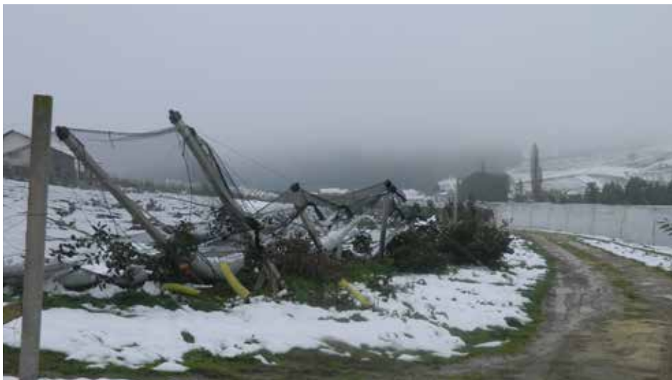
Slika 12: Posledice snegoloma - tudi betonski stebri ne prenesejo prevelikih obremenitev.
