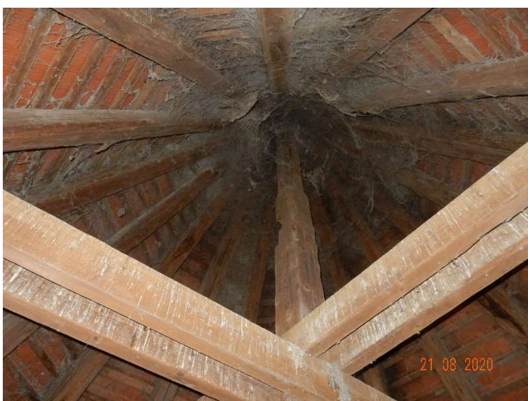
Slika 20: Osrednja podpora dim. 20/20 cm
