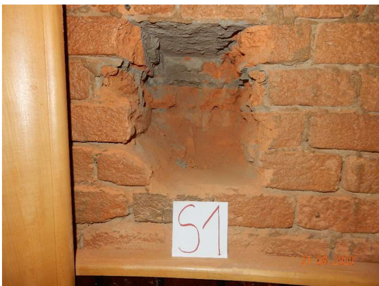
Slika 62: Zidna sonda S1; polni opečni zidaki normalnega formata, malta dobre kvalitete
