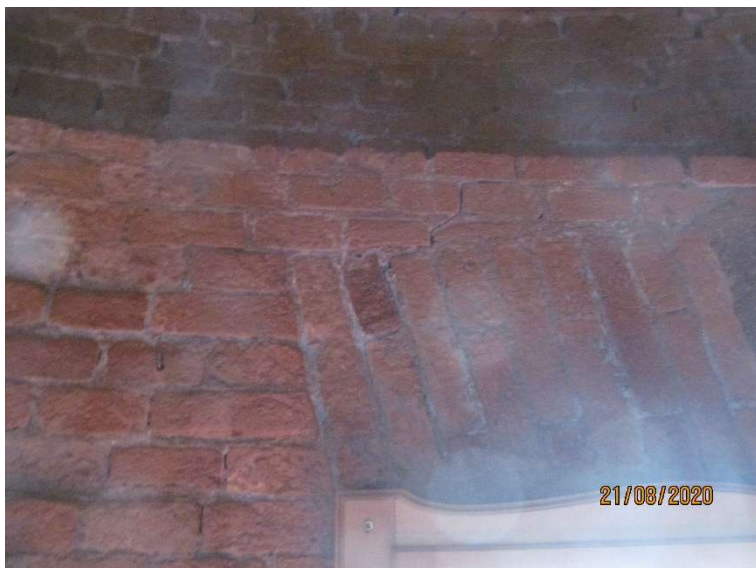
Slika 27 (Etaža-1): Poševna razpoka nad oknom
