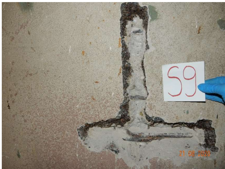
Slika 74: Preiskovalna sonda S9 na armiranobetonski steni rezervoarja; vgrajene gladke armaturne palice, nanešena izolacija iz plute in bitumna po obodu rezervoarja
