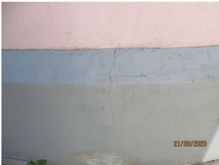
Slika 41 (Severna fasada - cokel): Vertikalna razpoka
