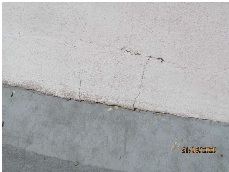
Slika 53 (Zahodna fasada): Razpoke zaradi razpadanja ometa nad coklom
