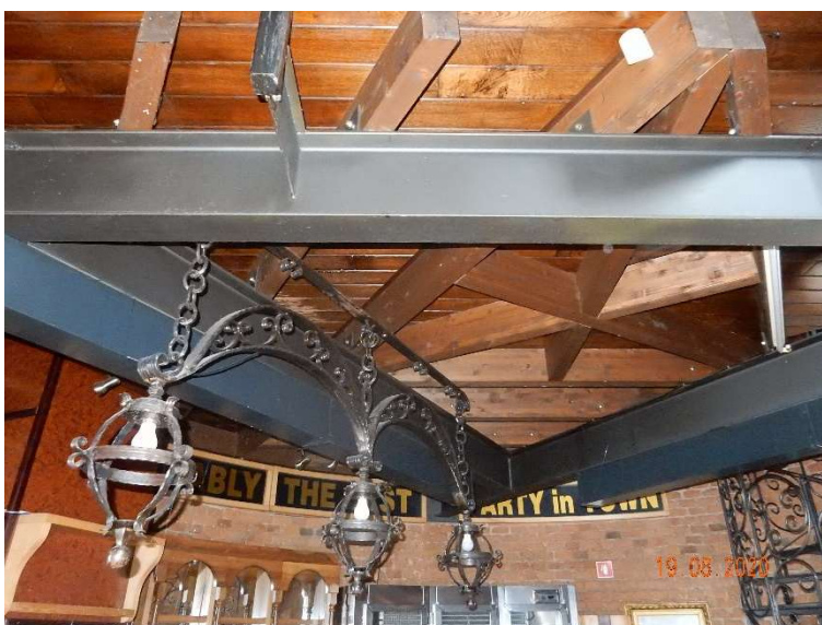
Slika 8: Primarna etažna konstrukcija – jeklena brana
