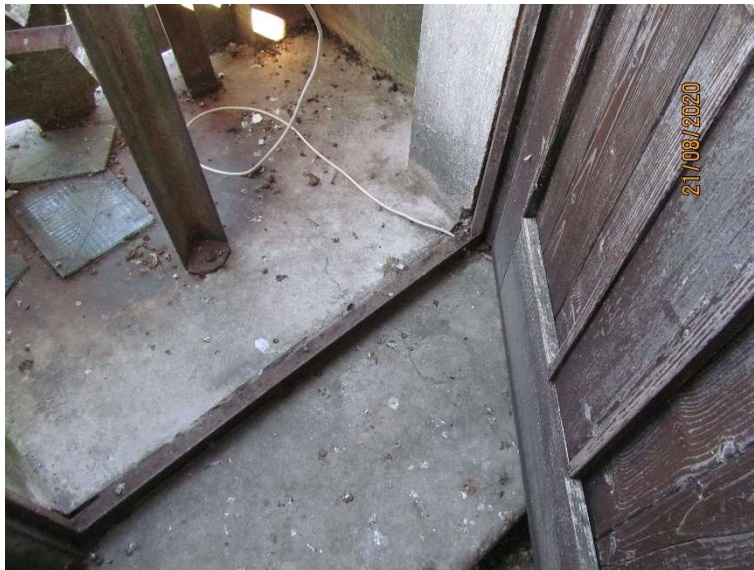
Slika 35 (Etaža-6): Prečna razpoka na balkonu in na pragu
