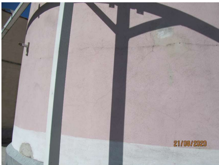
Slika 51 (Zahodna fasada): Mrežaste razpoke v fasadnem ometu nad coklom
