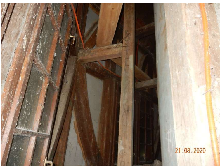
Slika 14: Lesena konstrukcija za fasadno oblogo po obodu vodohrama; nosilni leseni elementi dim. 15/15 cm
