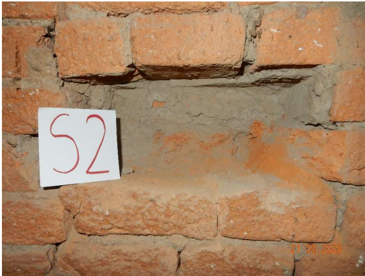
Slika 64: Zidna sonda S2; polni opečni zidaki normalnega formata, malta dobre kvalitete
