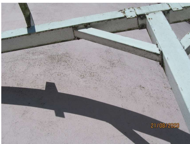
Slika 52 (Zahodna fasada): Mrežaste razpoke v fasadnem ometu v višini nadstreška
