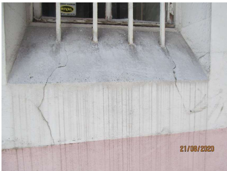
Slika 45 (Zahodna fasada): Vertikalni razpoki pod oknom
