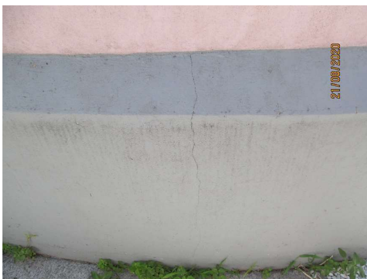
Slika 46 (Zahodna fasada - cokol): Vertikalna razpoka
