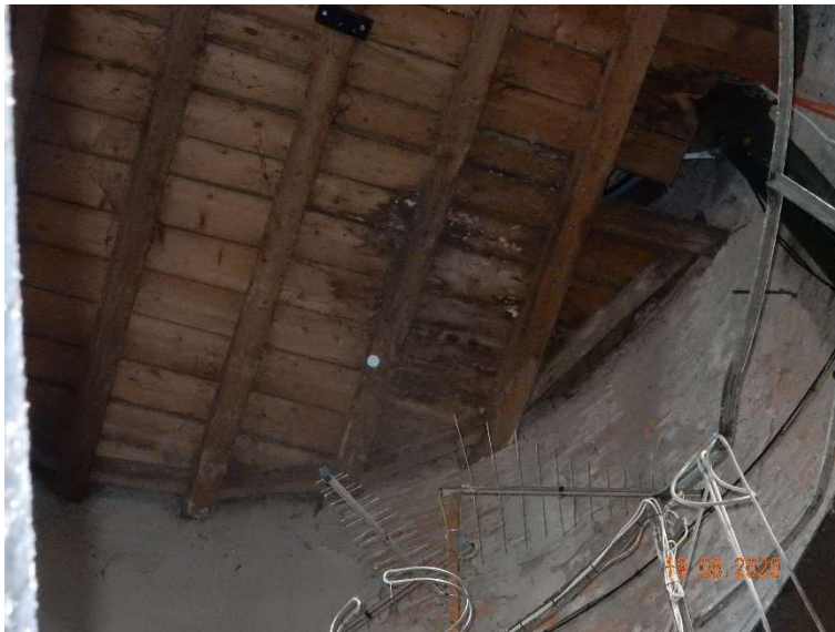
Slika 38 (Etaža-6, strop): Sledi zamakanja na leseni etažni konstrukciji
