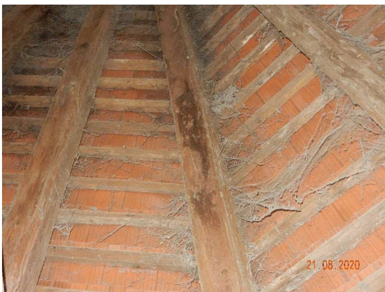
Slika 40 (Etaža-9, ostrešje): Sledi zamakanja na nosilni konstrukciji ostrešja
