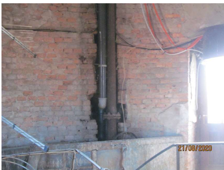
Slika 37 (Etaža-6): Oslabitev v nosilnem zidu (d=35cm, š=30cm) skozi več etaž
