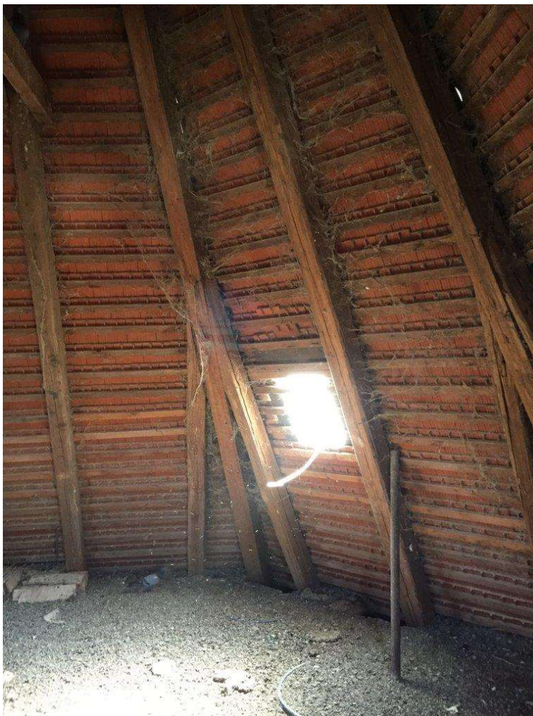
Slika 21: Leseni špirovci dim. 12/15 cm, vogalni špirovci dim. 12,5/15,5 cm
