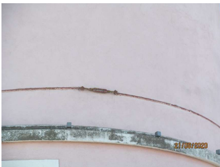
Slika 58 (Zahodna fasada): Korozija obodnih jeklenih vezi
