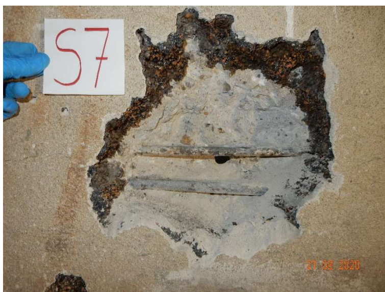
Slika 72: Preiskovalna sonda S7 na armiranobetonski steni rezervoarja; sonda izvedena nad odprtino za vstop v prostor med rezervoarjem in fasadno oblogo; vgrajene gladke armaturne palice
