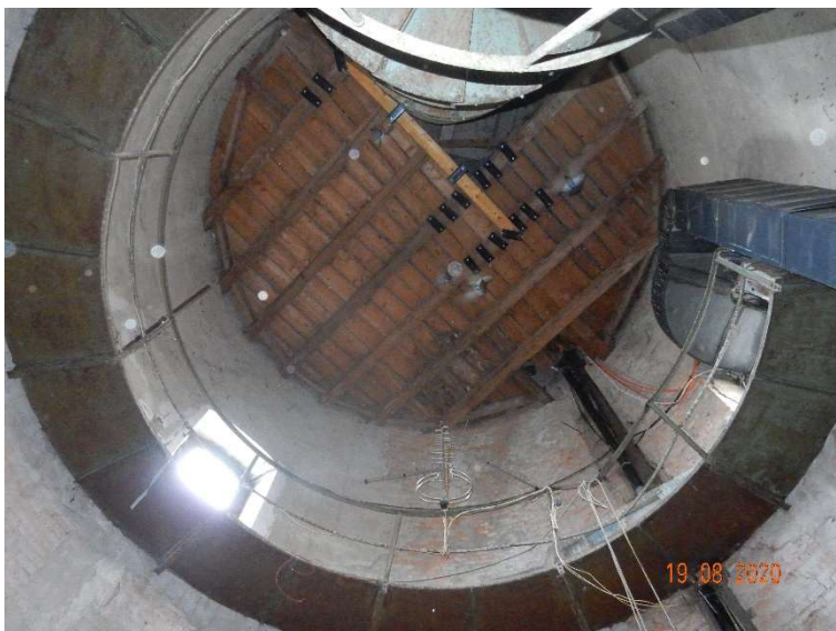
Slika 10: Jeklen podest po obodu in lesena etažna konstrukcija v slabem stanju
