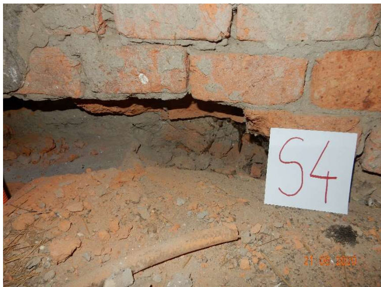
Slika 68: Zidna sonda S4; polni opečni zidaki normalnega formata, malta dobre kvalitete
