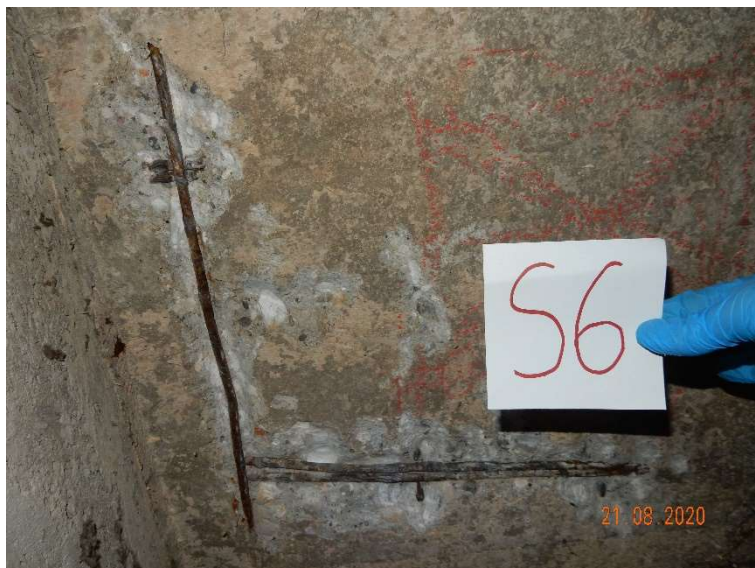
Slika 71: Preiskovalna sonda S6 na armiranobetonski plošči; vgrajene gladke armaturne palice
