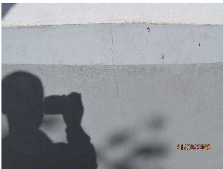
Slika 55 (Zahodna fasada - cokel): Vertikalna razpoka
