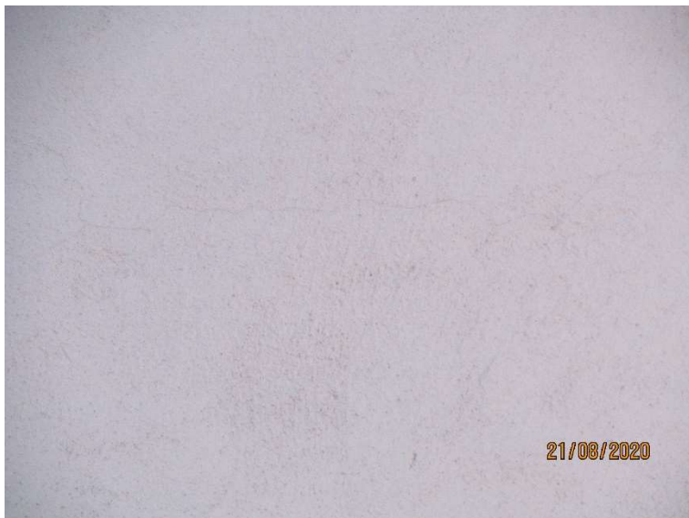
Slika 44 (Severna fasada): Mrežaste razpoke v fasadnem ometu
