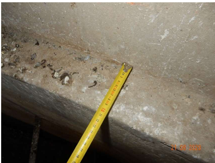
Slika 4: Zmanjševanje debeline zidvoja po višini
