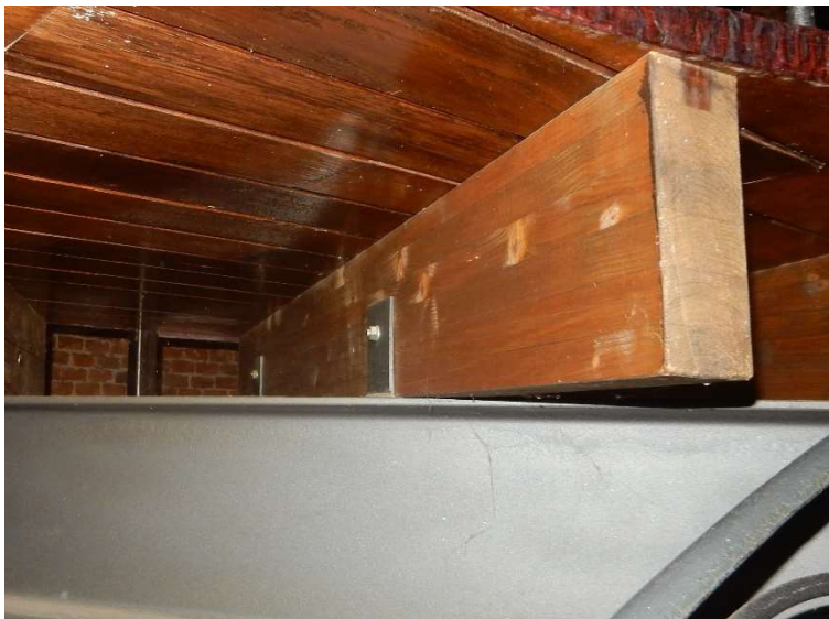
Slika 7: Pritrjevanje lesene sekundarne etažne konstrukcije na primarno
