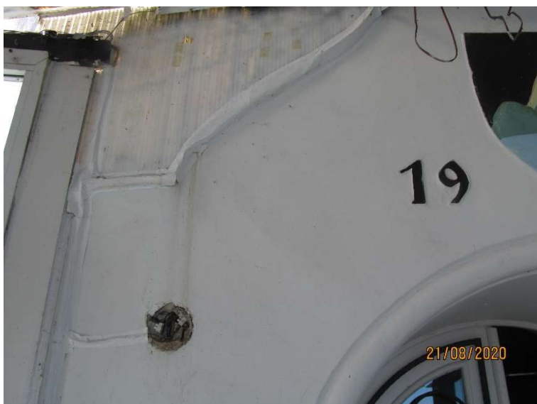
Slika 59 (Vzhodna fasada): Poševna razpoka nad vhodom
