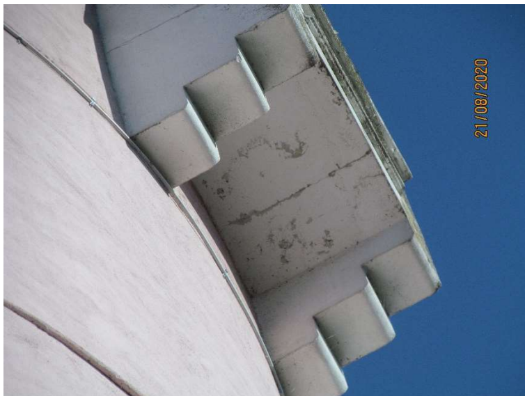
Slika 48 (Zahodna fasada – plošča balkona): Prečna razpoka
