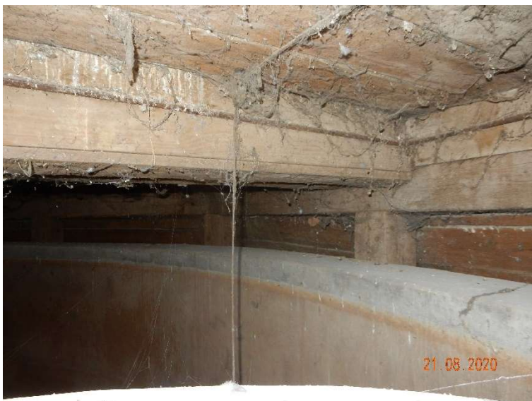
Slika 13: Stene vodohrama debeline 20 cm
