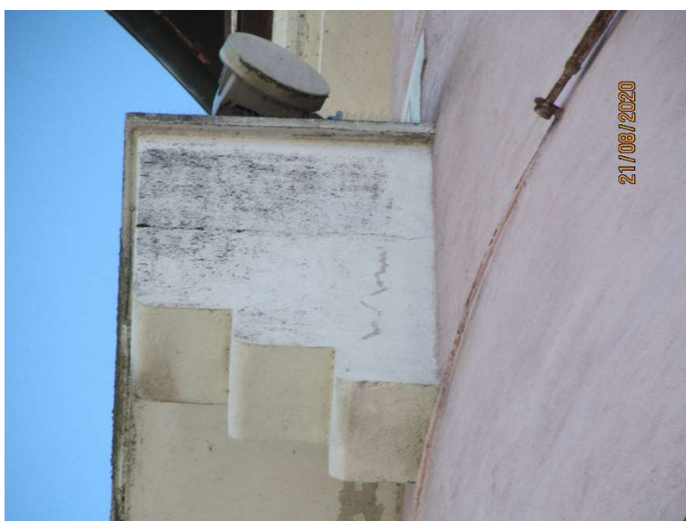
Slika 43 (Severna fasada): Vertikala in horizontalna razpoka na parapetu balkona
