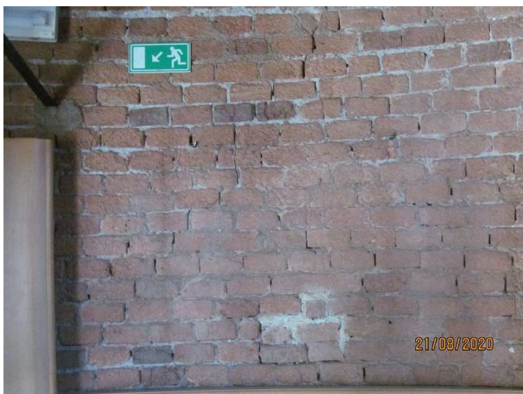
Slika 28 (Etaža-1): Poševna razpoka v zidu, mestoma rege med zidaki niso zapolnjene v celoti
