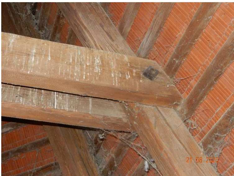
Slika 19: Stikovanje škarij na špirovec preko svornika, škarje so dim. 7/18 cm
