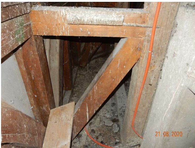
Slika 15: Lesena konstrukcija za fasadno oblogo po obodu vodohrama; nosilni leseni elementi dim. 15/15 cm
