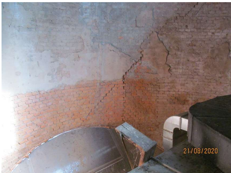
Slika 30 (Etaža-4): Vertikalna in poševna razpoka, ki gre skozi več etaž
