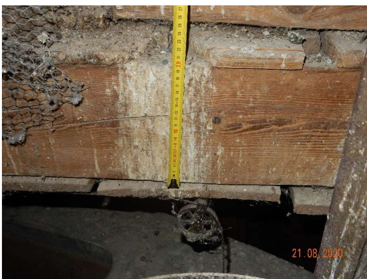
Slika 17: Lesena etažna konstrukcija med vodohramom in ostrešjem; nad zgornjim slojem desk vgrajen estrih debeline 3,0 cm iz slabega betona; zaznati povečane vibracije ob hoji
