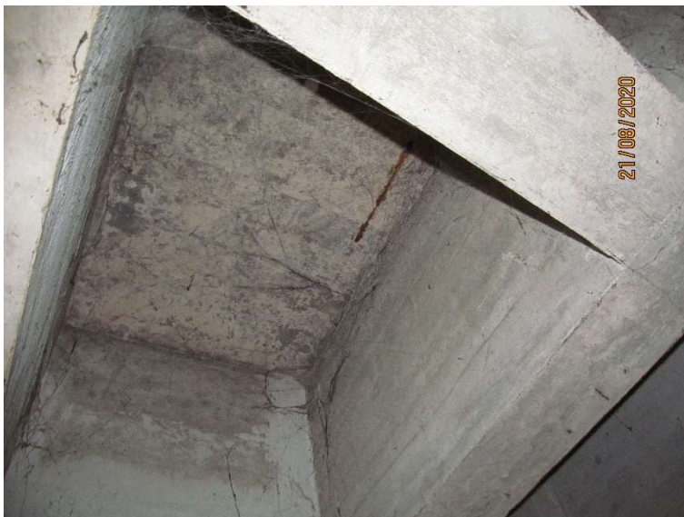
Slika 39 (Etaža-7, strop): Vidna korodirana armatura v nosilcih in plošči vodohrama
