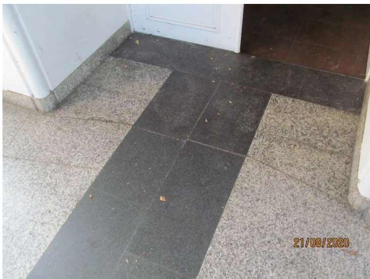
Slika 60 (Vzhodna fasada): Razpoke v tlaku pred vhodom
