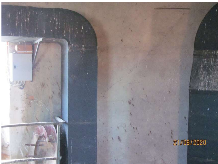
Slika 36 (Etaža-6): Poševna razpoka v ometu
