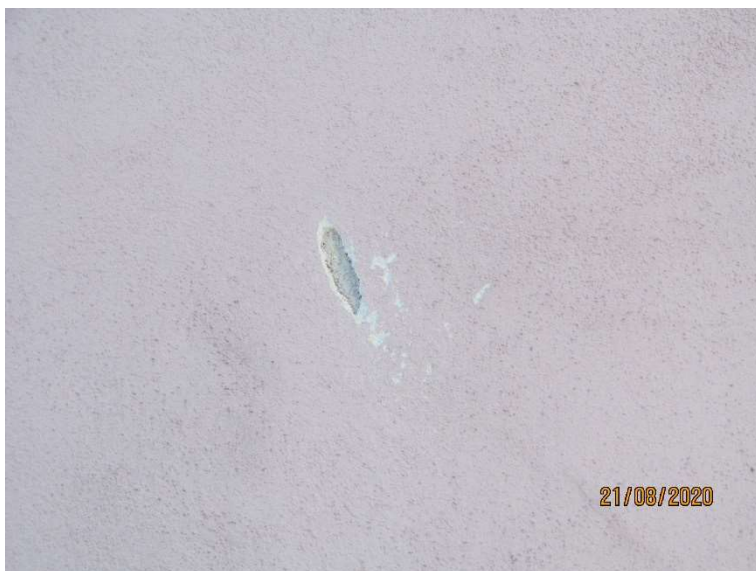
Slika 42 (Severna fasada): Mehanska poškodba na fasadnem ometu
