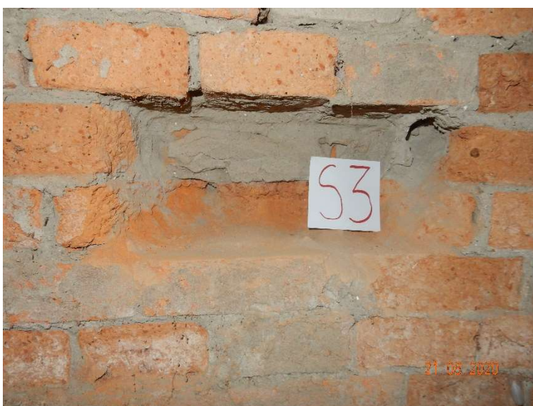
Slika 66: Zidna sonda S3; polni opečni zidaki normalnega formata, malta dobre kvalitete
