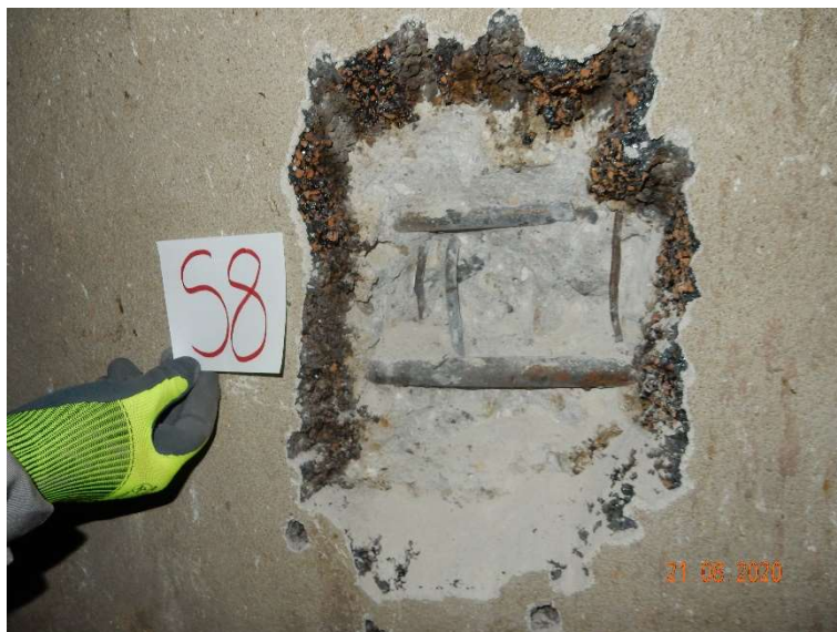
Slika 73: Preiskovalna sonda S8 na armiranobetonski steni rezervoarja; vgrajene gladke armaturne palice, nanešena izolacija iz plute in bitumna po obodu rezervoarja
