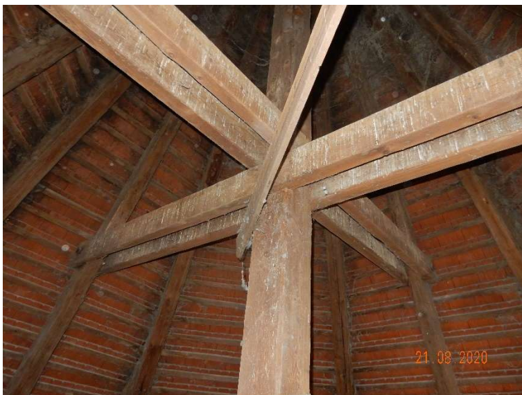
Slika 18: Leseno ostrešje, strešna kritina je opečni bobrovec; nosilni elementi v relativno dobrem stanju
