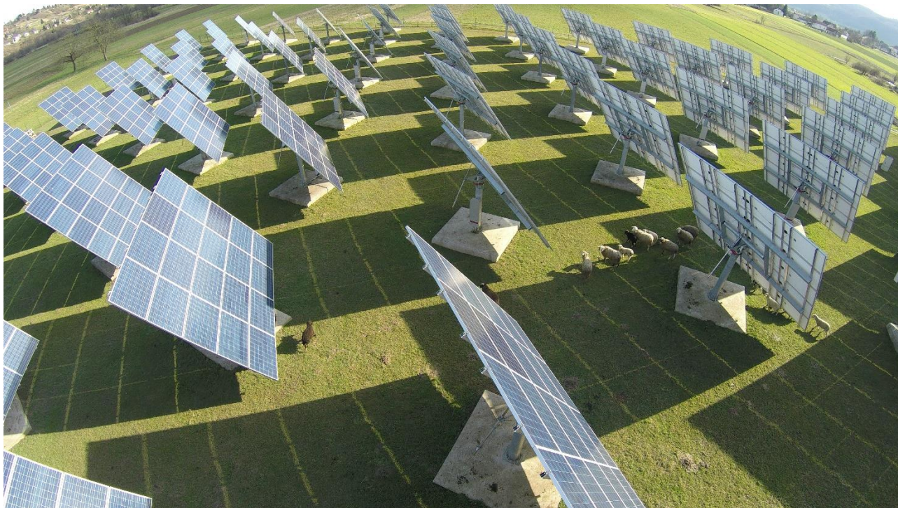
Slika 4: Obstoječa fotonapetostna naprava investitorja Vrata Deržič, Rudolf Deržič s.p. s sledilnim sistemom, ki ga je razvil in proizvedel investitor sam (vir: Vrata Deržič)
