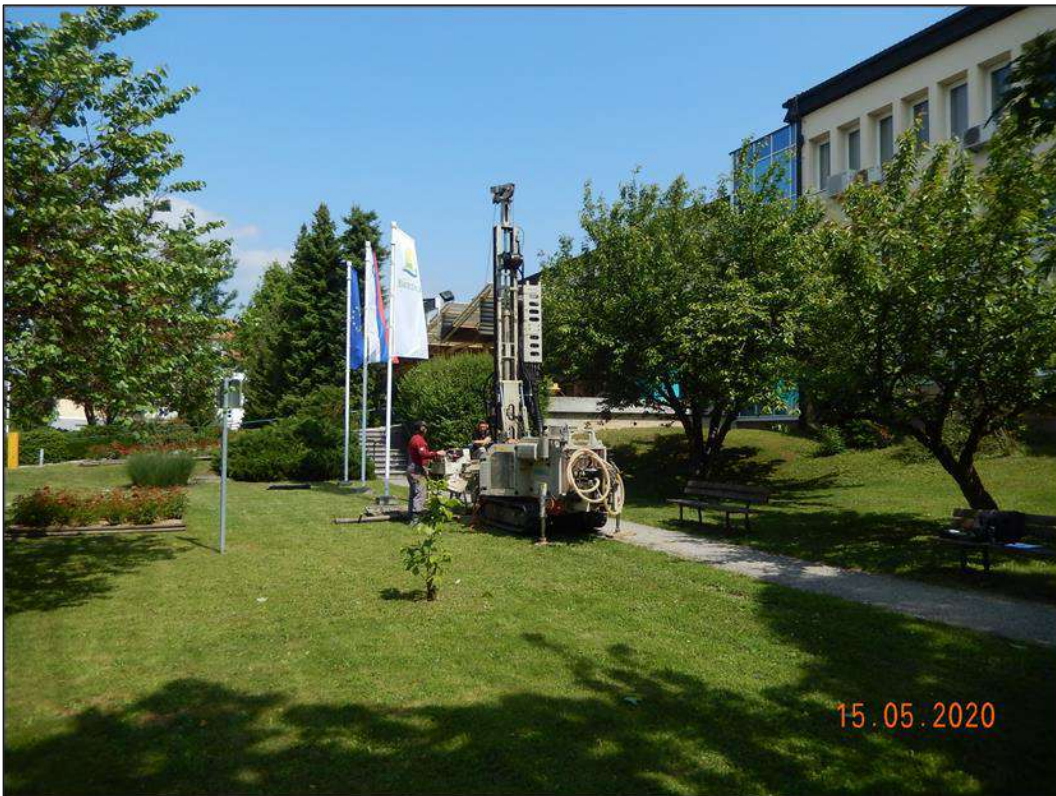
Lokacija sondažne vrtine V-2 (Foto: 15. 05. 2020)
