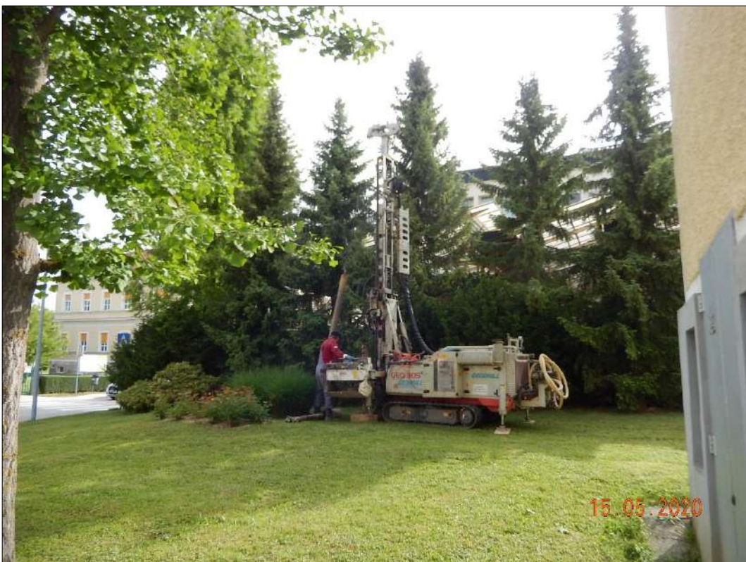
Lokacija sondažne vrtine V-1 (Foto: 15. 05. 2020)
