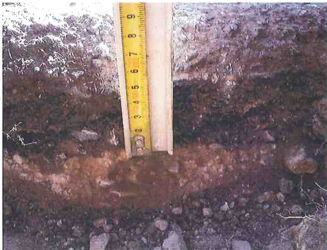
Slika 7: Debelina asfaltne utrditve skupaj 10cm (6+4)
