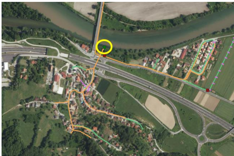
Slika 9: Razbremenilnika na kanalu Čatež ob Savi – iztok v vode
