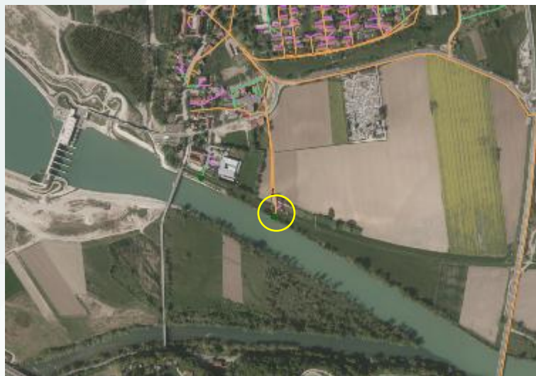
Slika 5: Zaključek razbremenilnega kanala meteornih vod pod gradom Brežice – iztok v vode
