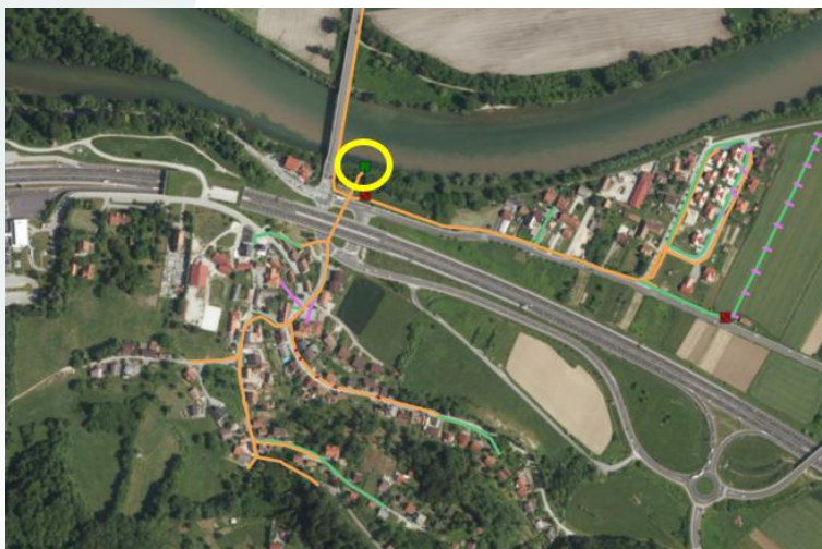
Slika 8: Razbremenilnika na kanalu Čatež ob Savi – iztok v vode
