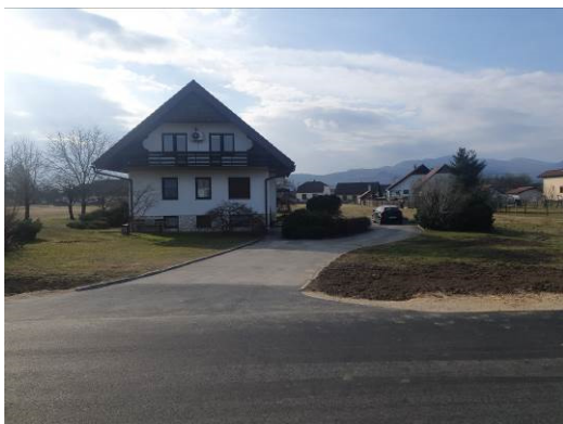
Stanovanjska hiša – sever
