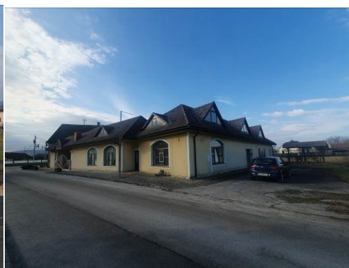
Poslovni objekt - jugovzhod
