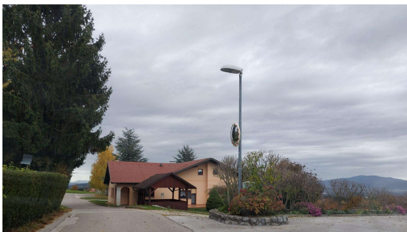
Stanovanjska stavbe ob lokalni cesti
