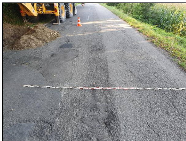
Slika 7: Tipične poškodbe okoli km 0,220 (levo) in okoli km 0,460 (desno), sept. 2020
