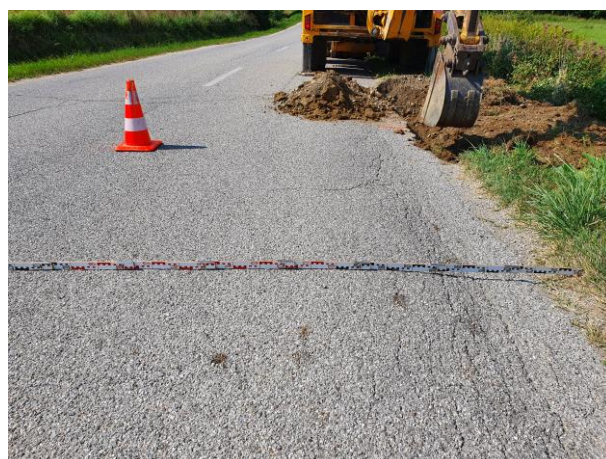
Slika 10: Tipične zmrzlinške poškodbe in nenosilno prirobje okoli km 2,570 sept. 2020
