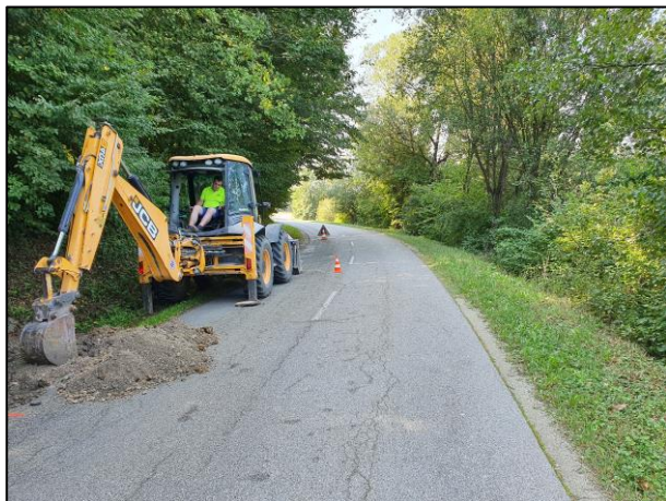
Slika 16: Sondažni razkop SJ-6, sept. 2020
