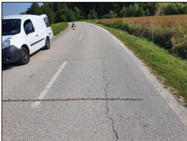
Slika 10: Tipične zmrzlinške poškodbe in nenosilno prirobje okoli km 2,570 sept. 2020
