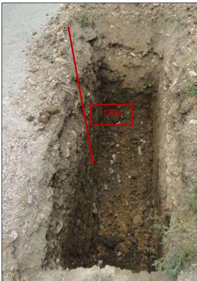
Slika 4. Sondažni razkop J1 na končni globini 1,20m.
