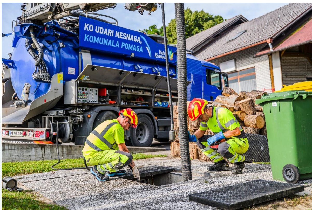
Slika 3: Čiščenje črpališča pri Stadionu Brežice
