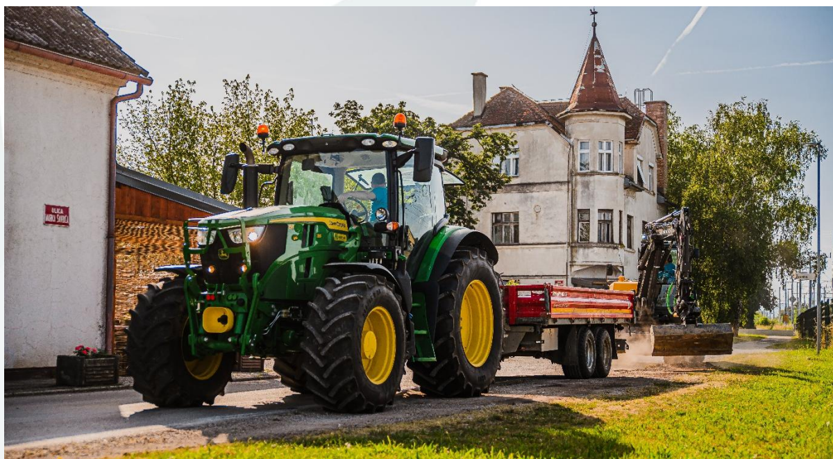
Slika 6: Delo na vzdrževanju cest
