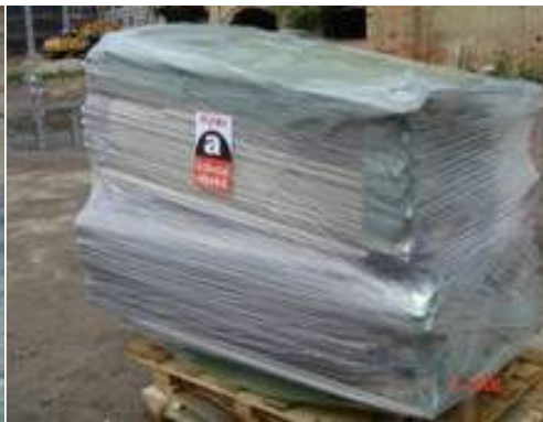
Slika2: Trdo vezani azbestni odpadki
