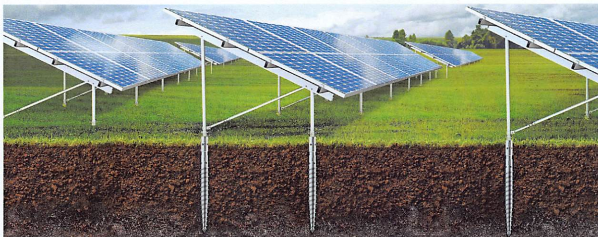
Slika 9: Prikaz točkovne pritrditve oz. vijačenja kovinske stebrne podkonstrukcije v tla v primeru FE Brezje.
