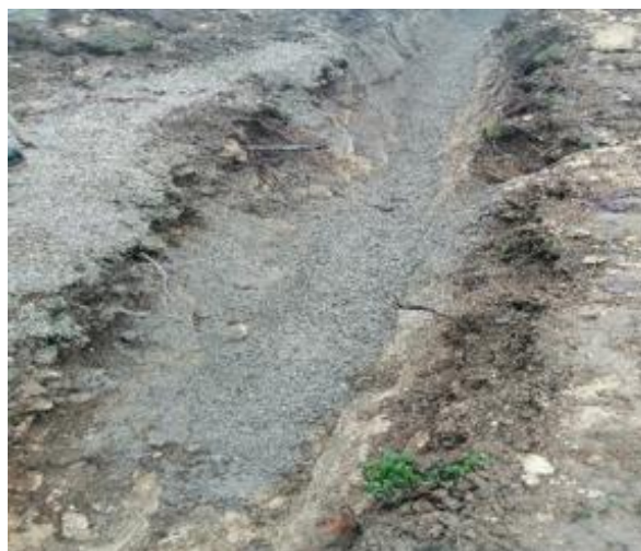
Slika 8: Priprava posteljice za vodovod Cerina
