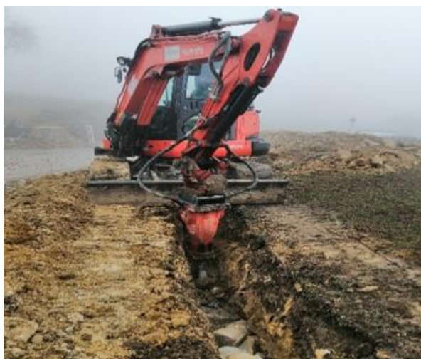
Slika 7: Izkop kanala za vodovod Vrhovnica
