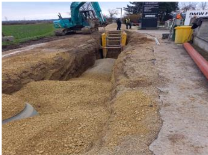
Slika 9: Postavitev zaščitnih opažev na fekalni kanalizaciji Dobova
