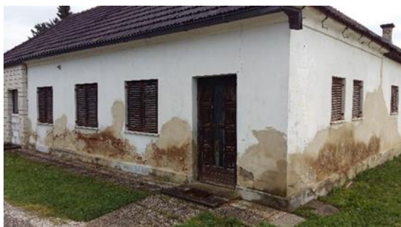
Stanje pred sanacijo
