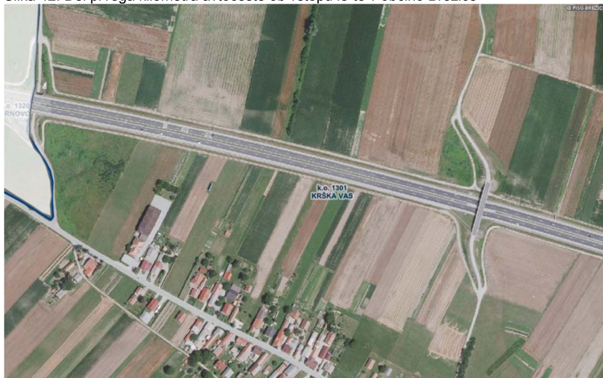
Slika 42: Del prvega kilometra avtoceste ob vstopu le-te v občino Brežice
