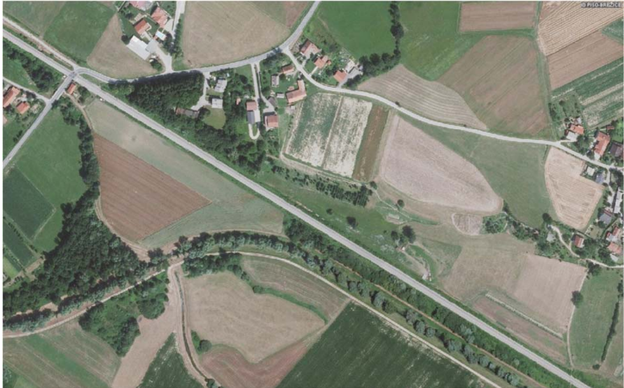
Slika 49: Del šestega in sedmega kilometra železniške proge
