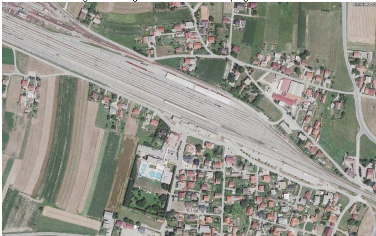
Slika 53: Del devetega in desetega kilometra železniške proge
